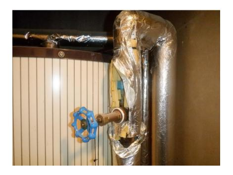
現在状況 減圧弁場所変更箇所 電気温水器 補給水配管 ※配管途中に 圧力調整可能な 減圧弁を新規設置
