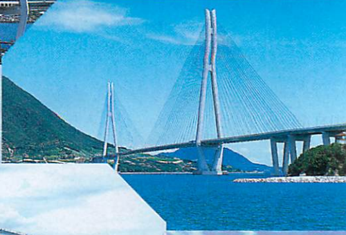
多々羅大橋
