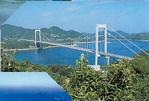
伯方・大島大橋 写真提供 本州四国連絡高速道路(株)
