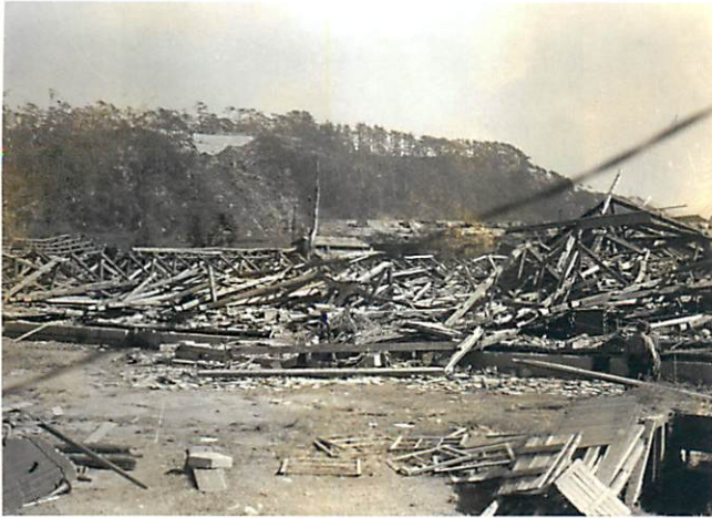
5-1. 爆風で倒壊した木造の建物
