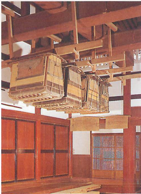
土間と籠：上部のはりは松の芯材だけを使い、その周囲は約2m。ここから屋根最頂部の内側を見ることができる。
