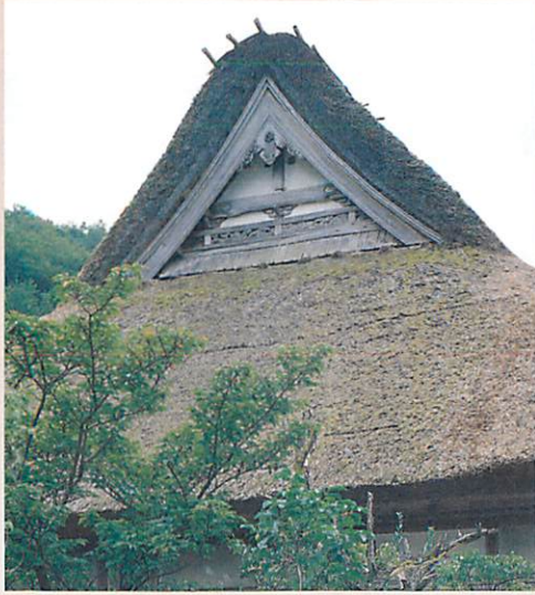
茅葺大屋根側面：最頂部は地上18m。4～5階建ビルを、木と茅で作ったようなもの。
