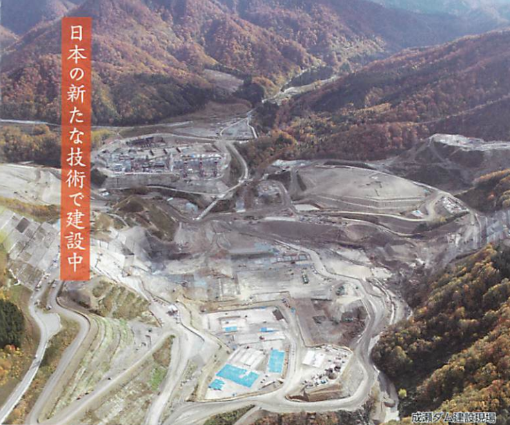
成瀬ダム建設現場
